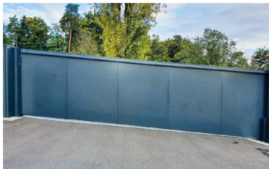
Schrägbau-Schiebetor mit Glattblechfüllung
