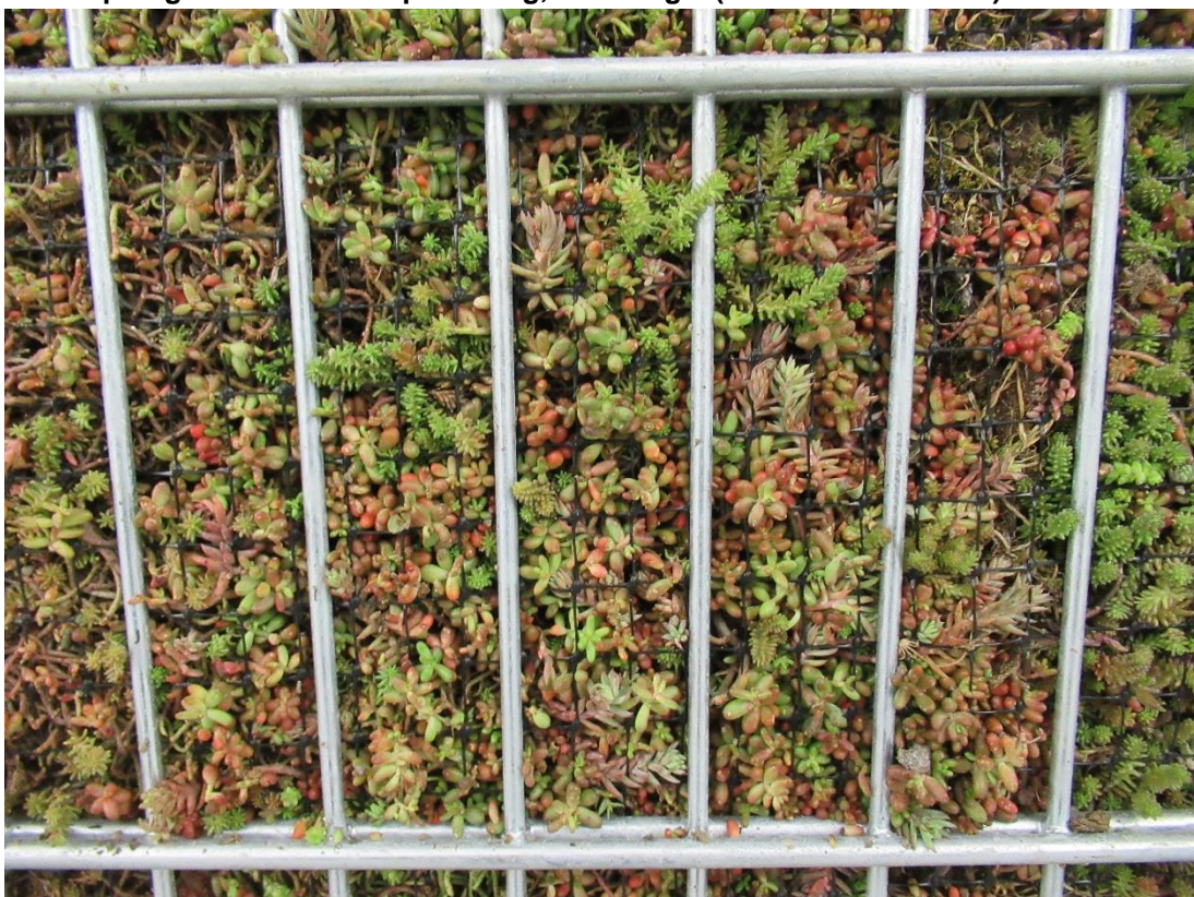
Bild 6: Ansicht Empfangsraum Detail Bepflanzung, Messung 1 (Pflanzen Gabione 1)
