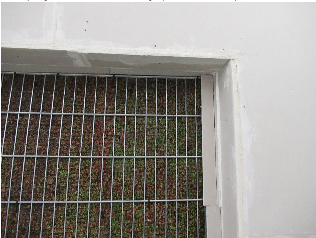
Bild 4: Ansicht Empfangsraum Detail oben, Messung 1 (Pflanzen Gabione 1)
